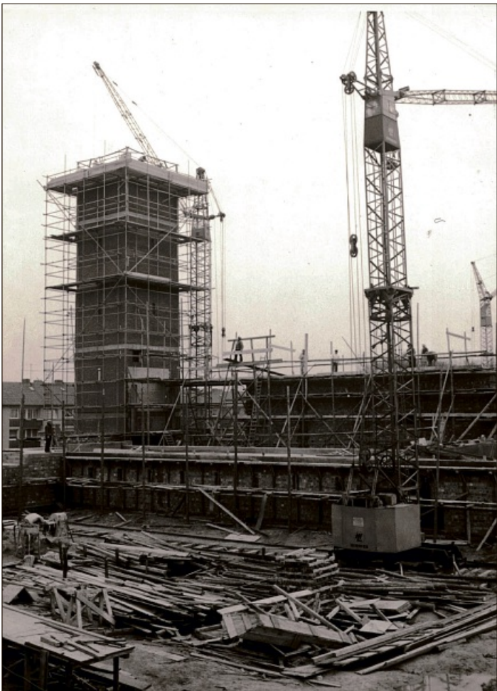
Bau der St. Michaeliskirche 1962. Am 21. Januar war die Grundsteinlegung und bereits im Juni Richtfest.
