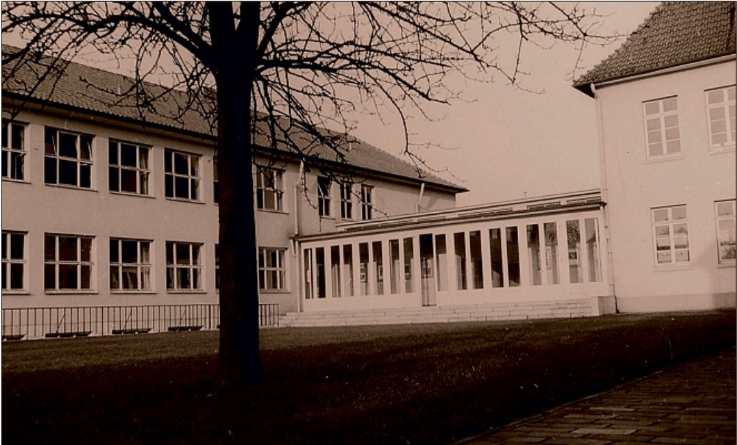
Helle Räume , klare Gänge und ein schöner Hof nach hinten, umfasst vom Hufeisen der beiden Altbauten und des Neubaus 1956. Doch die „Raumnott“ löste auch der zweite Anbau nicht auf Dauer. „Wanderklassen“ entstanden.
